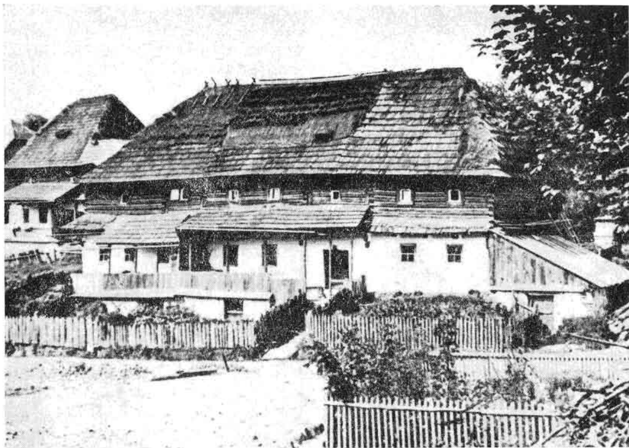
24. V banických lokalitách delením a dedením jednotlivých priestorov domu sa vyvinulo viacej obytných buniek pod jednou strechou, Kunešov (okr. Žiar n. H.), stav z 30. rokov 20. stor.
